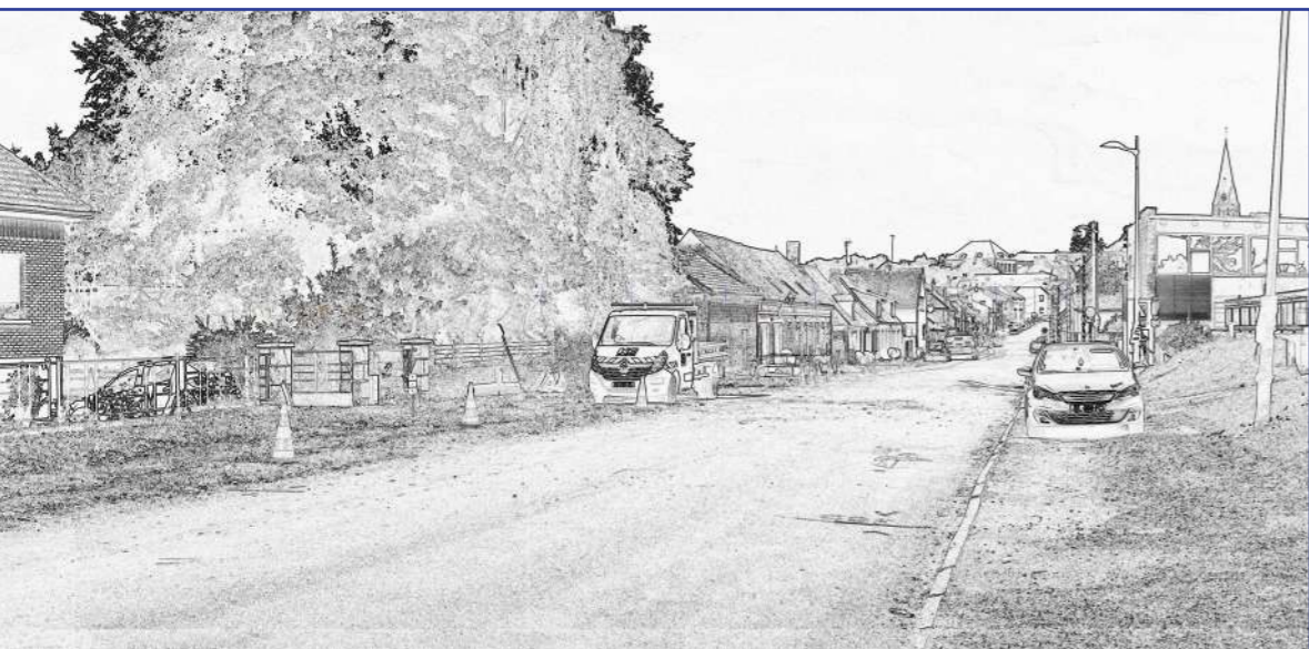
AMURE - Projet du parc éolien des Marnières
